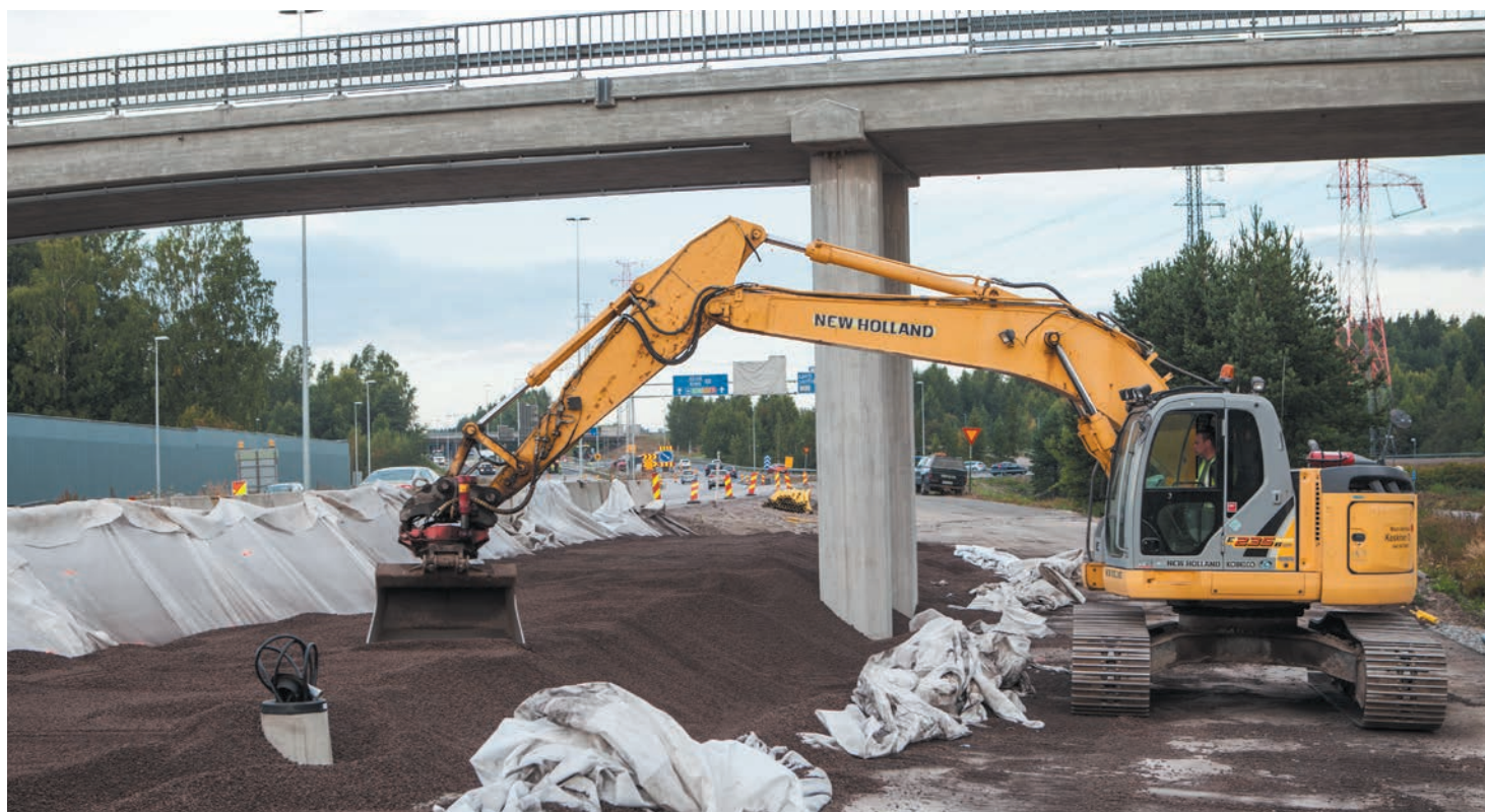
Foto 3.3 Leca® kergkruustäide Helsingi välimise ringtee Kehä III ehitusobjektidel
