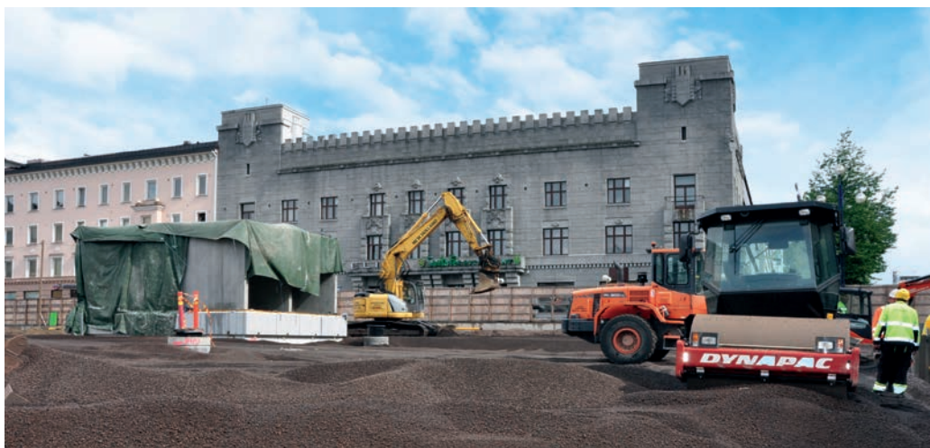
Foto 5.6 Leca® Lahti Toriparkki kattekonstruktsioonis.
