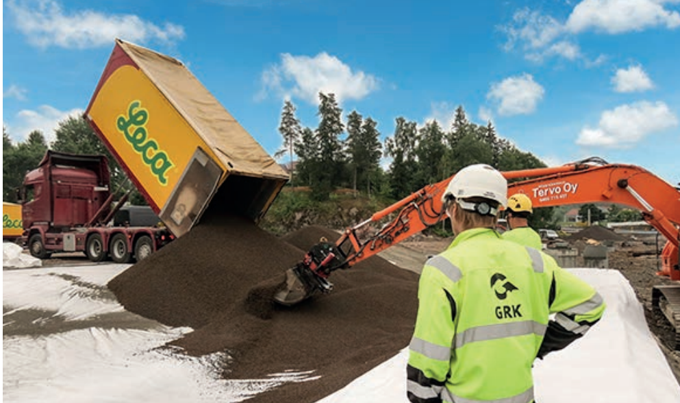
Foto 6.6. Kergkruusa täiskoormaga tarne objektile.
