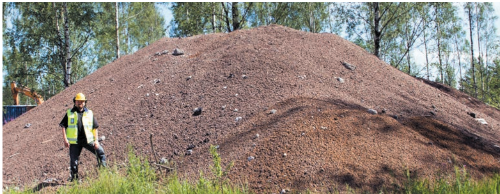
Foto 3.5 Helsingi sisemisse ringtee Kehä I remondi- ja laiendustöödel kaevati Leca® kruus vanast konstruktsioonist välja ja võeti taaskasutusse.
