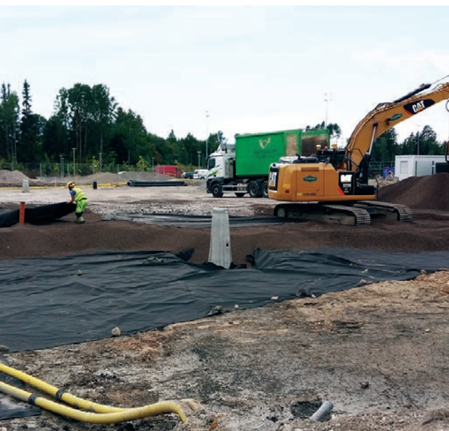
Foto 5.7 Leca® kruus Klaukkala üritusväljaku aluskonstruktsioonis.
