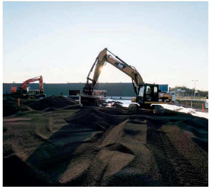
Foto 6.2 Leca® kergkruusa täite paigaldamine buldooseri ja ekskavaatoriga planeerides ja eeltihendades.
