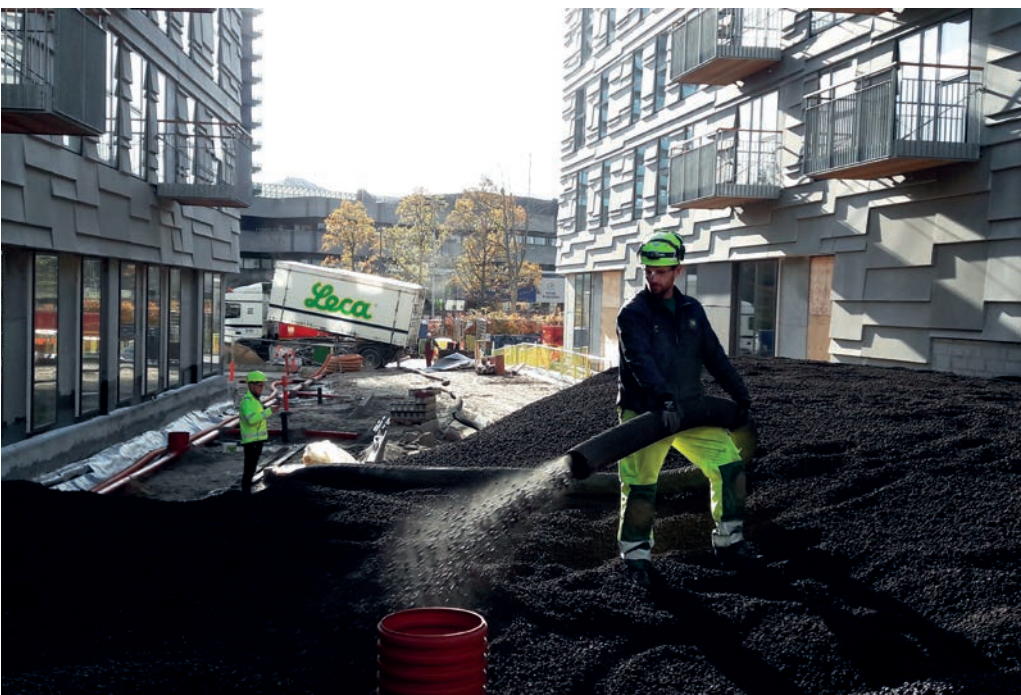
Foto 6.7. Kergkruusa paigaldamine puhuriga.
