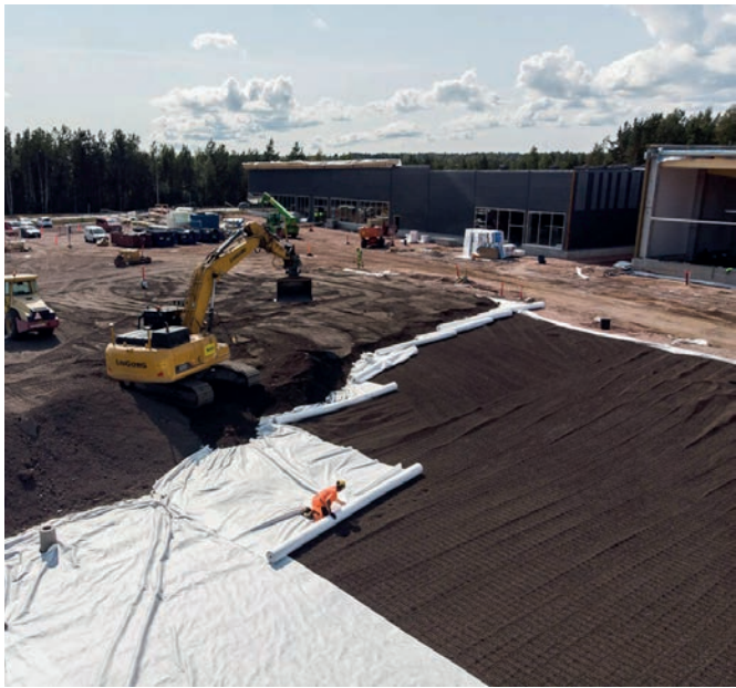
Foto 6.2 Leca® kergkruusa täite paigaldamine buldooseri ja ekskavaatoriga planeerides ja eeltihendades.
